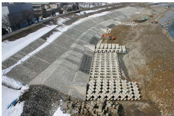
急流河川対策（根継ぎ護岸工）
